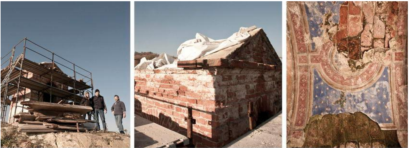
ristrutturazione della Cappella dell'Ascensione
